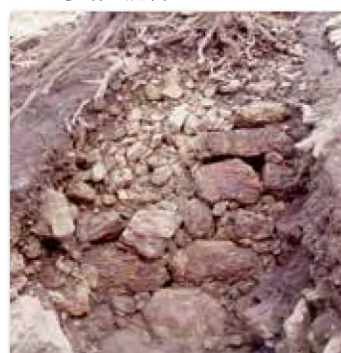
被熱により赤く変色した石垣
